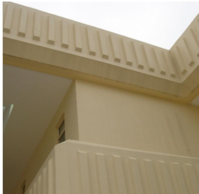
拼接完灰缝应用灰刀勾平，使grc构件成为一体。干燥后，若grc构件拼缝处留有多余粘结砂浆可用砂纸进行打磨。干燥后□grc构件拼接部位抗裂\*\*胶进行处理。处理方法见抗裂\*\*胶使用说明。施工完的grc构件就注
