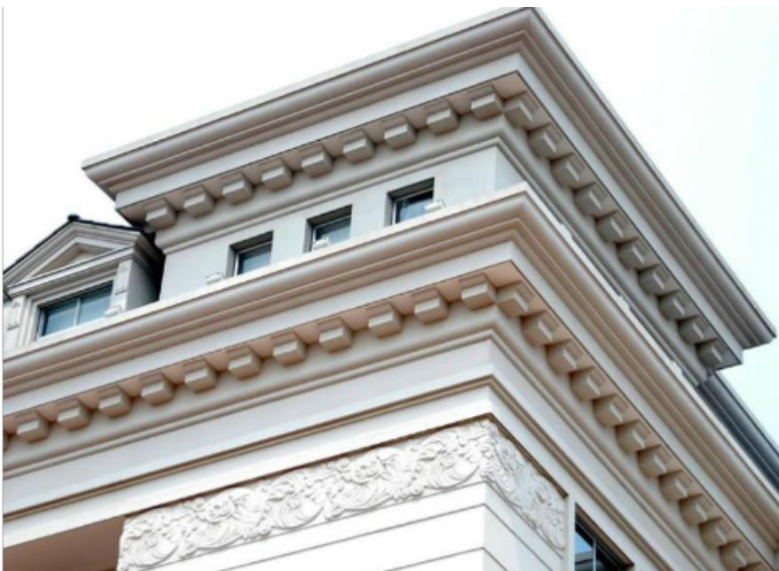
1、无限可塑性GRC产品是将原料按一定配比搅拌，在模具内浇筑成型，可生产出造型丰富，质感多样的产品。可根据客户和设计师的不同需要，进行任意的艺术造型，完美实现设计师的设计梦想。2、质量轻、强度高GRC的体积密度约为1.8-1.9,8mm厚标准GRC板重量\*为15kg□抗压强度超过40Mpa□抗弯强度超过34Mpa□\*\*超过国际标准要求。3、超薄技术、尺寸大GRC板\*\*薄可做到5mm□标准宽度为900mm和1200mm□长度不限，满足运输条件即可，亦可做成5mm至任意厚度，任意尺寸。德宏实体店GRC线条常见问题GRC装饰线条□GRC角线□GRC门窗套。
